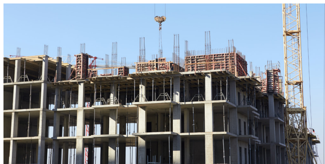
Construction et équipement lourd
